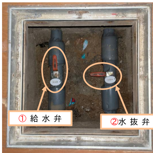
通水時（水道使用中）の状態
